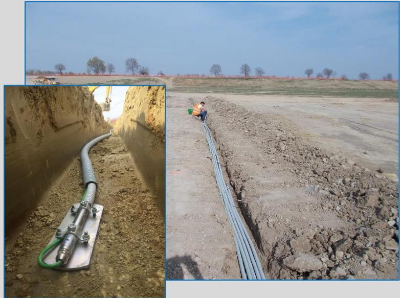
Gli assestimetri sono collegati attraverso un circuito idraulico ad un serbatoio di riferimento, installato all'esterno dell'area influenzata da eventuali cedimenti/assestamenti. Pertanto ogni strumento è costituito essenzialmente da un trasduttore di pressione relativo e da una tubazione idraulica.
