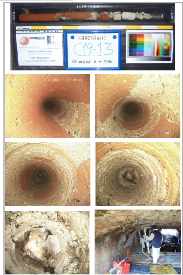
Figura 4 – Carotaggio di un'opera in muratura e calcestruzzo, e dettagli dell'esame endoscopico.
