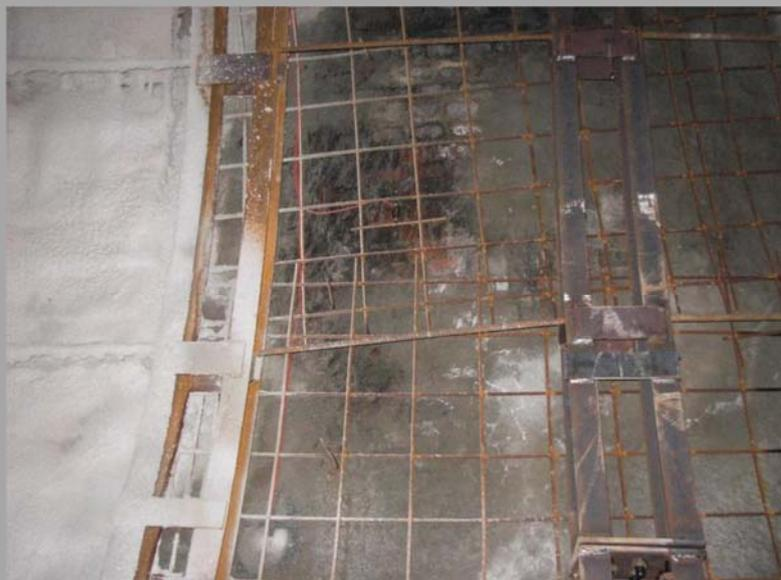
Le barrette si basano sul principio della corda vibrante: contengono un filo in acciaio teso tra due estremità che vengono ancorate alla struttura da monitorare. Le deformazioni della struttura causano un movimento relativo tra i due ancoraggi e una variazione della tensione del filo che genera una variazione nella frequenza di vibrazione.
